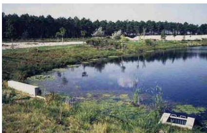
Bassin de retenue
