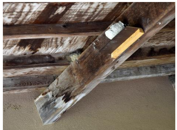
Figure 24. Réalisation et pose d'un nid artificiel pour les hirondelles, préau de l'école © Gilles Lecuir
